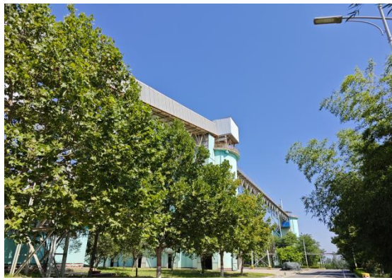
管线、皮带走廊物见本色
