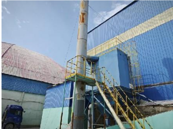
DA052-改造后（采样口上移符合前四后二，重新设 50mm 以下采样孔管，设置固定电源）
