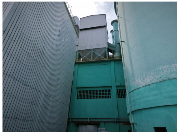
辊压机、水泥磨封闭良好
