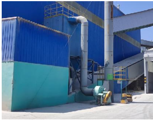
DA052-改造前（不满足前四后二，采样孔管过长，未设置固定电源）
