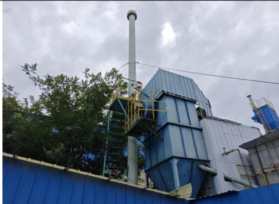
DA056-改造后，重新设置采样孔管
