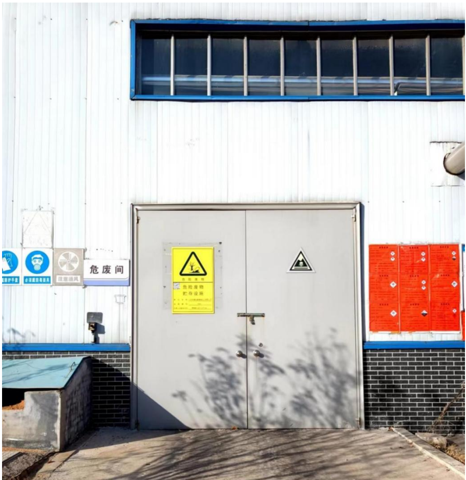
图 2.3-8 厂区危废库现状
