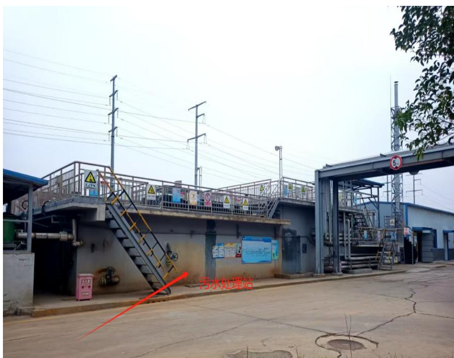
图 2.3-5：厂区污水处理站
